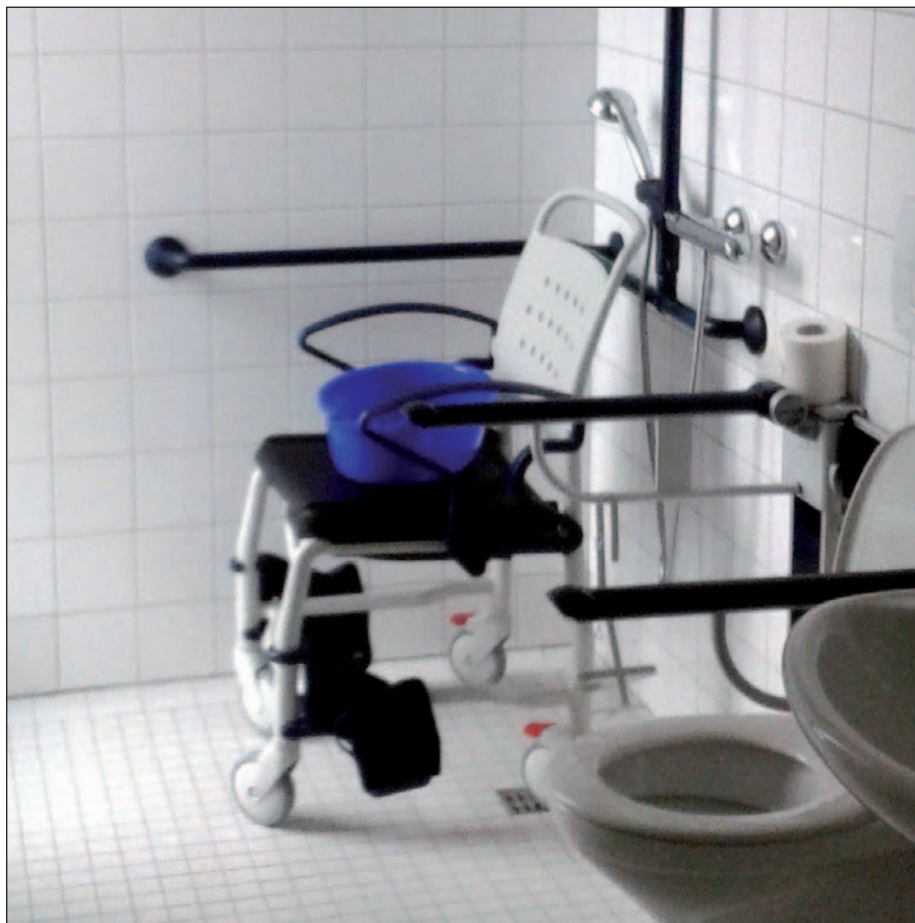
Bodengleiche Dusche, Haltegriffe, Toilettenerhöhung – gerade im Sanitätsbereich gibt es viele Verbesserungsmöglichkeiten. Foto: Dangel-
