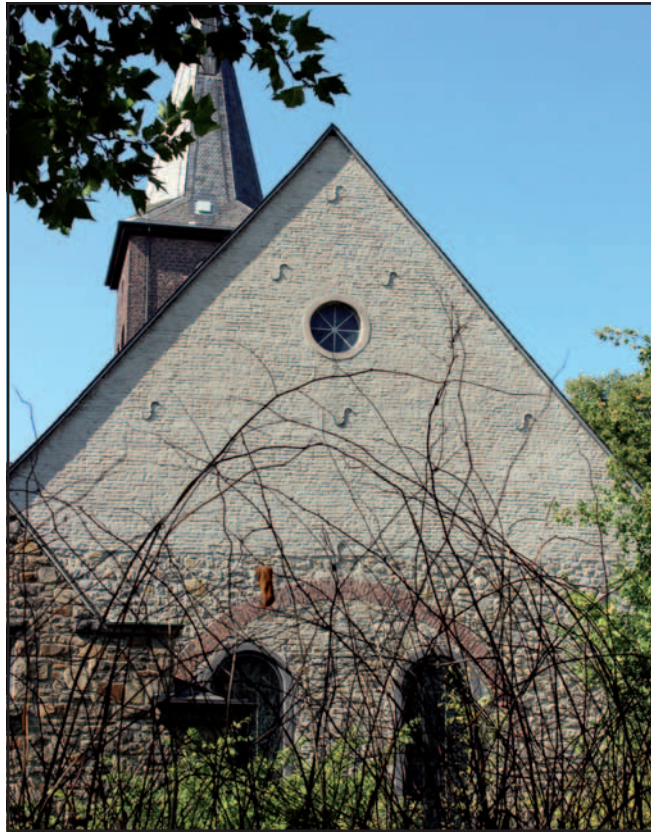
Die Reformierten errichteten ihre Kirche in der Nähe des ehemaligen Lintorfer Tores: die heutige evangelische Stadtkirche. Sie ist einer der ältesten reformierten Kirchenbauten des Bergischen Landes. Der gemauerte Bogen an der östlichen Giebelwand deutet darauf hin, dass ursprünglich ein halbrunder Chorabschluss vorgesehen war.
