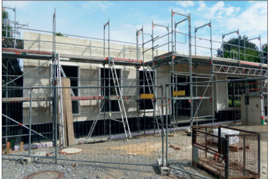
Der Rohbau des Mehrgenerationentreffs Tiefenbroich steht, jetzt werden Fenster eingebaut und Dachdeckerarbeiten ausgeführt. Foto: J. Dangelmeyer
