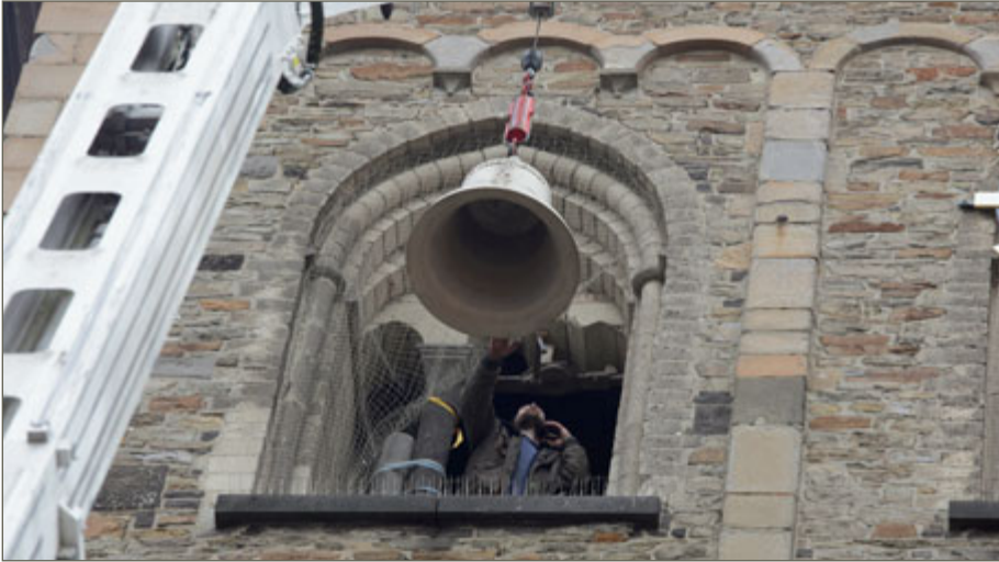
Millimeterarbeit: Die Glocke wurde mit einem Kran noch oben gezogen und ins Innere gehievt. Foto: V. Schrimpf
