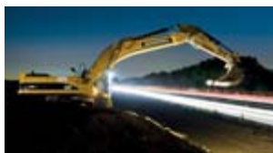
ERD-, TIEF-, STRASSENBAU
