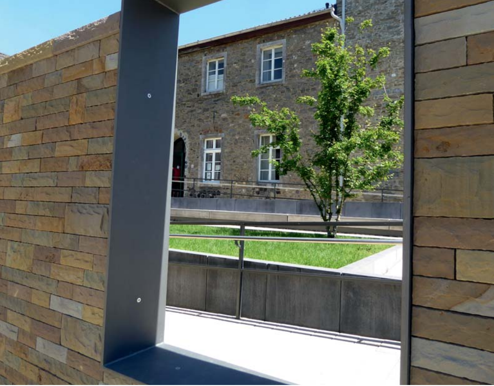
Die großen Fensteröffnungen in der Mauer sollen den Raum des Klosters mit dem Hochzeitsgarten hin zum neuen Rathaus öffnen. Foto: J. Dangelmeyer
